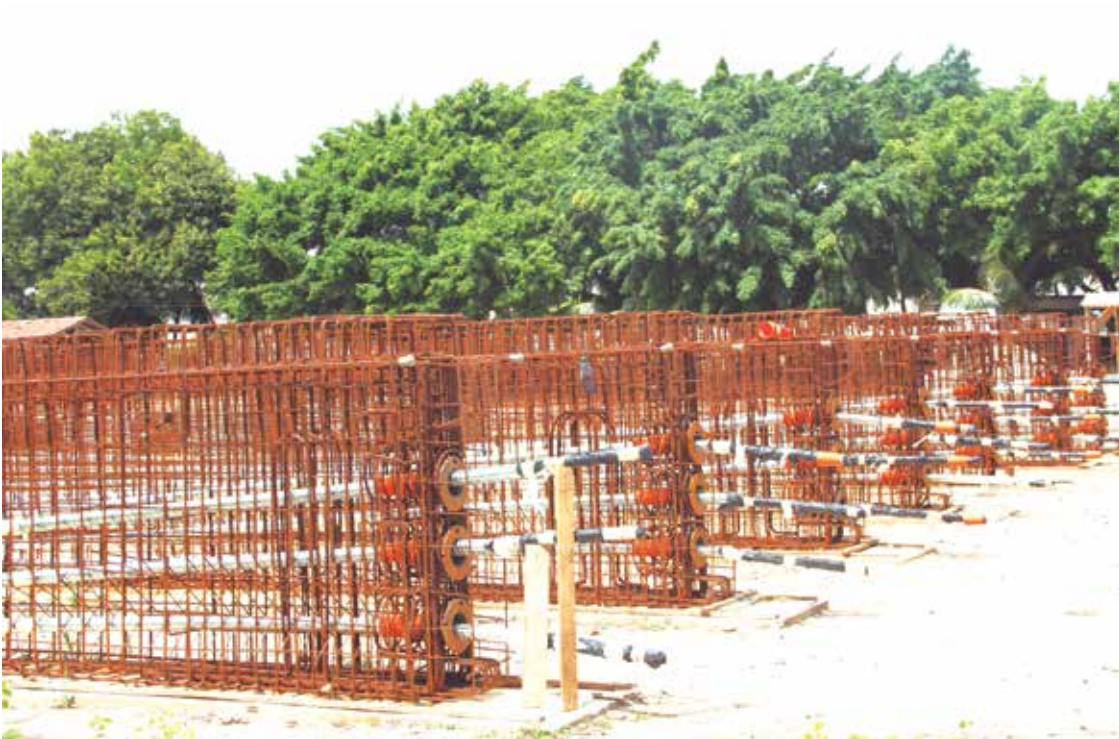
Local onde o DER construirá o viaduto interligando as Três Ruas, no Bancários, à UFPB; próximo à Praça da Paz foi instalado um canteiro de obras para montagem das 30 vigas de sustentação da estrutura
