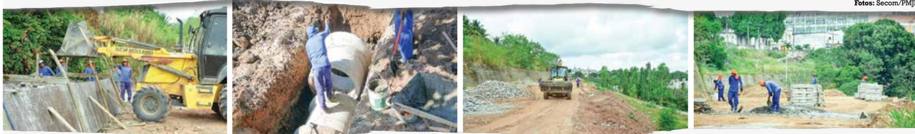
Nessa primeira etapa do projeto, as obras focam a construção de galerias de águas pluviais, galerias de esgotos, terraplenagem, nivelamento de ruas e remoção de entulhos em vários locais
