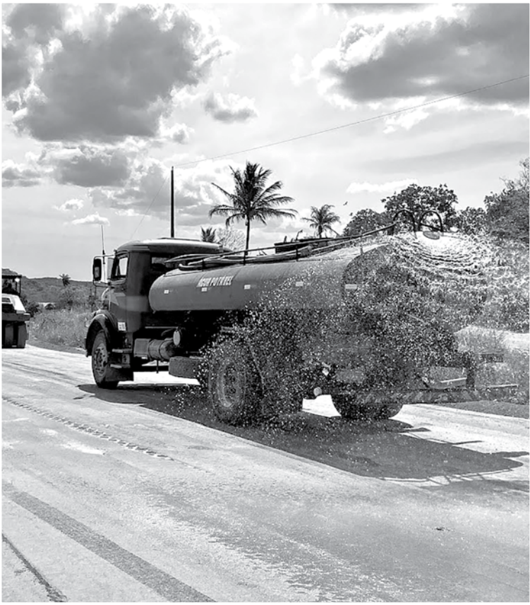
Entre os serviços, estão sendo executados serviços de terraplenagem em cortes e aterros, pavimentação da pista de rolamento e acostamentos em tratamento superficial duplo
