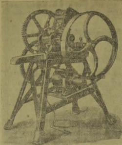
(Combinação de Moenda de Cana com motor Electrico Funcionamento Immediato)
