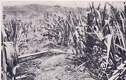
Canal em curva de nível na usina S. Maria. No clichê vê-se o cano despejando, a 30 metros de altura, a água puxada pelo motor-bomba
