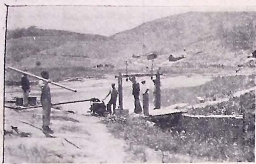
Reservatório d'água que serve para a irrigação dos canaviais da usina S. Maria. No clichê vê-se o motor-bomba do Departamento de Irrigação da Escola de Agronomia do Nordeste
