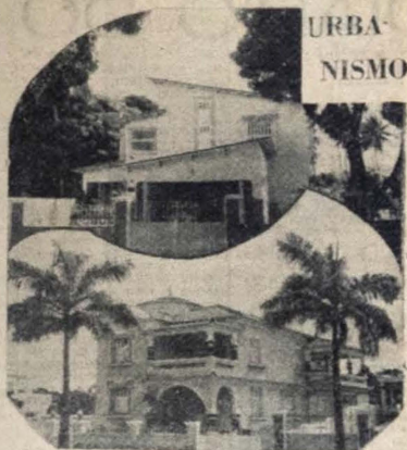
UMA nova orientação arquitetônica se vem constatando nesta cidade. No clichê acima, vemos dois modelos recentemente construídos e que revelam a técnica que vem presidindo a remodelação das potências urbanísticas da Capital. Residência do Eng. Speridião Gabinio de Carvalho Junior, na Av. D. Pedro II e do Industrial Alvaro de Vasconcelos, na Av. Getúlio Vargas.
