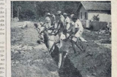
Foto cedida pela reportagem fotográfica desta folha, ontem, no núcleo residencial do IAPETC de Jaguaribe, onde o Governo do Estado está executando a rede elétrica e esgoto.
