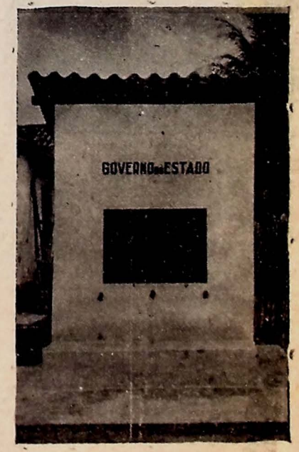
CHAFARIZ NA CRUZEIRO DO SUL — O chafariz que aparece na foto acima foi construído pelo Governo, por intermédio do Departamento de Saneamento do Estado, na rua Cruzeiro do Sul no bairro de Cruz das Armas. Segunda-feira próxima o Governador fará a entrega da obra ao povo daquela arteria suburbana
