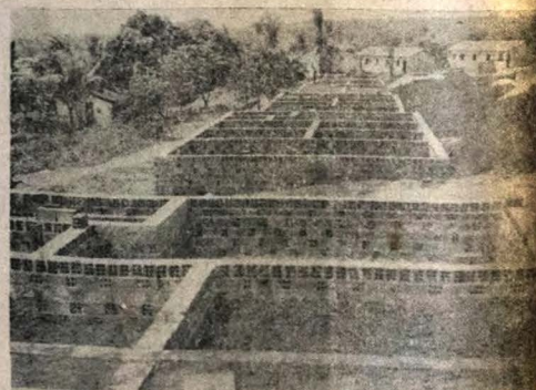
As obras de construção prosseguem em ritmo acelerado
