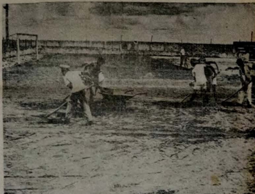
RAPOSO COMANDA — Os trabalhos de recuperação da "Graça" estão em pleno andamento. O engenheiro João Raposo, titular da Secretaria de Viação da Prefeitura de João Pessoa, conforme o clichê, comanda pessoalmente os serviços de terraplanagem do gramado. Brevemente, serão iniciados os trabalhos de alongamento das arquibancadas.
