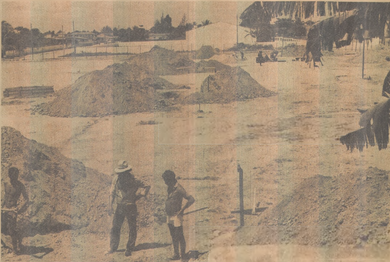
As fundações do Espaço Cultural, em Tambauzinho, já foram iniciadas pela construtora
