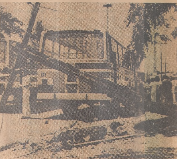
O poste foi totalmente destruído
