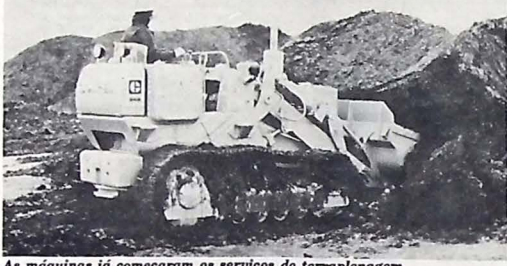
As máquinas já começaram os serviços de terraplenagem
