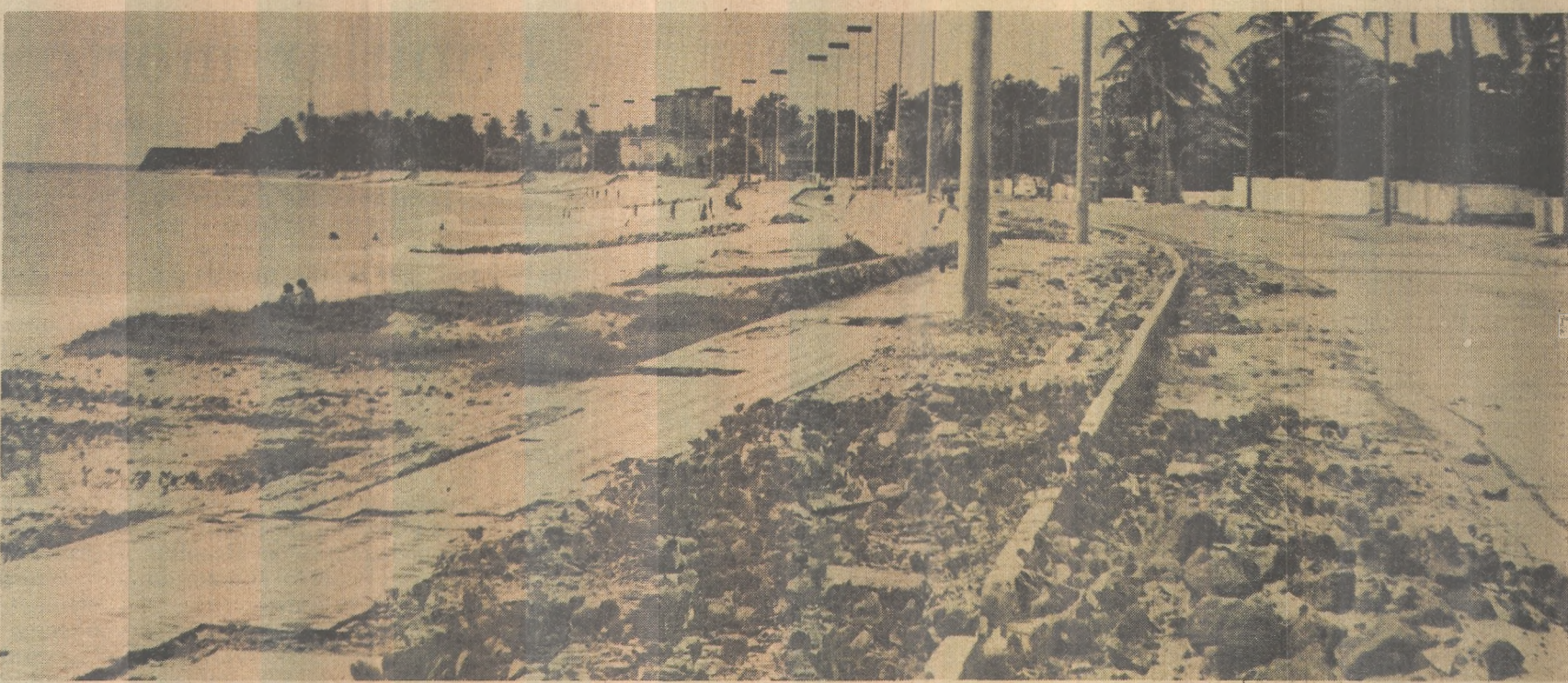
Falha nos projetos provocaram a paralisação do Cura nas áreas de Tambaú/Bessa e Rangel/Cristo
