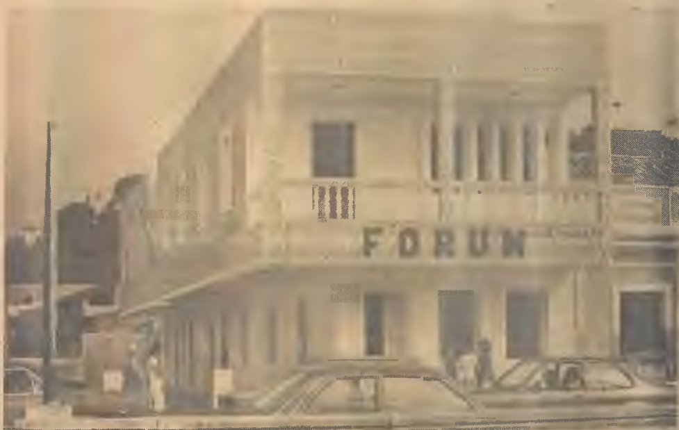
Novo prédio do Forum de Bananeiras já em pleno funcionamento
