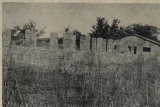
Estádio construído pela metade na propriedade "Conselho"
