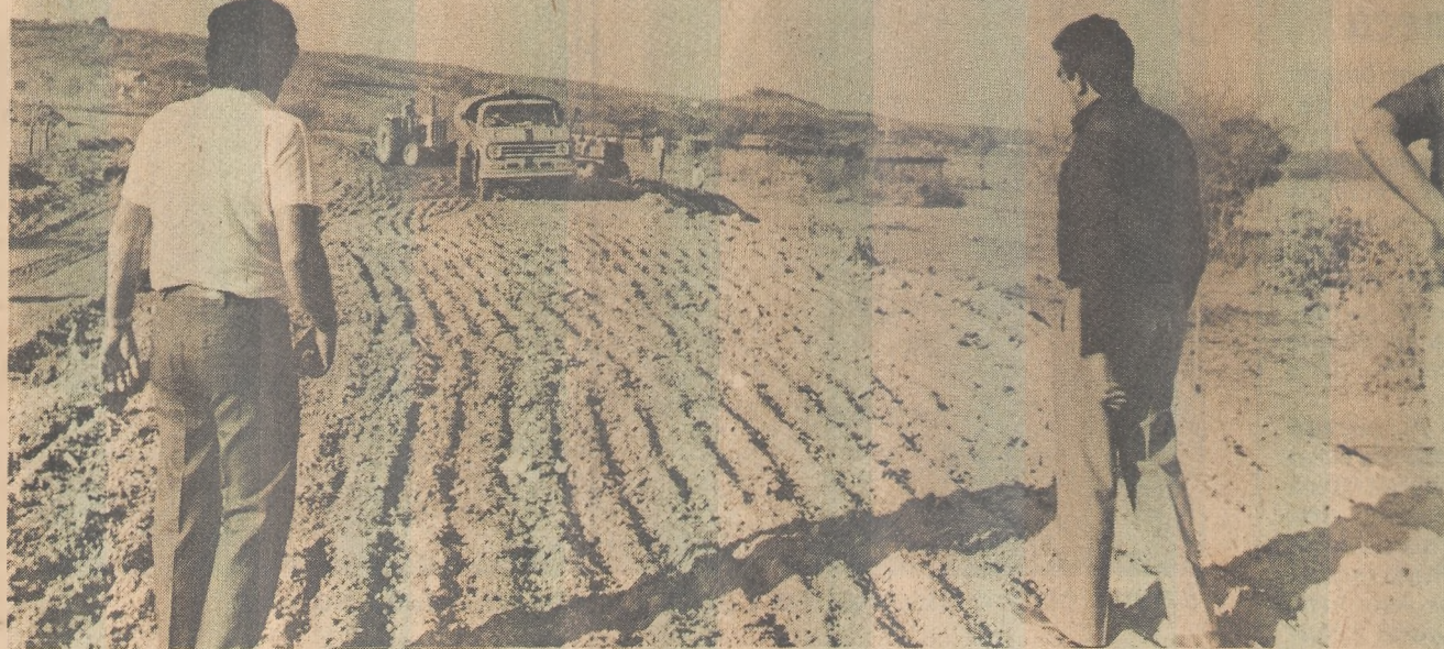
Técnicos fiscalizam os trabalhos de construção das estradas no interior
