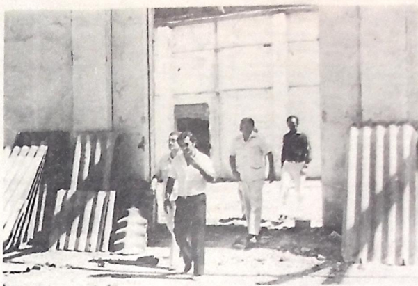
Damásio foi ver os operários da Prefeitura demolindo o prédio da firma Abílio Dantas
