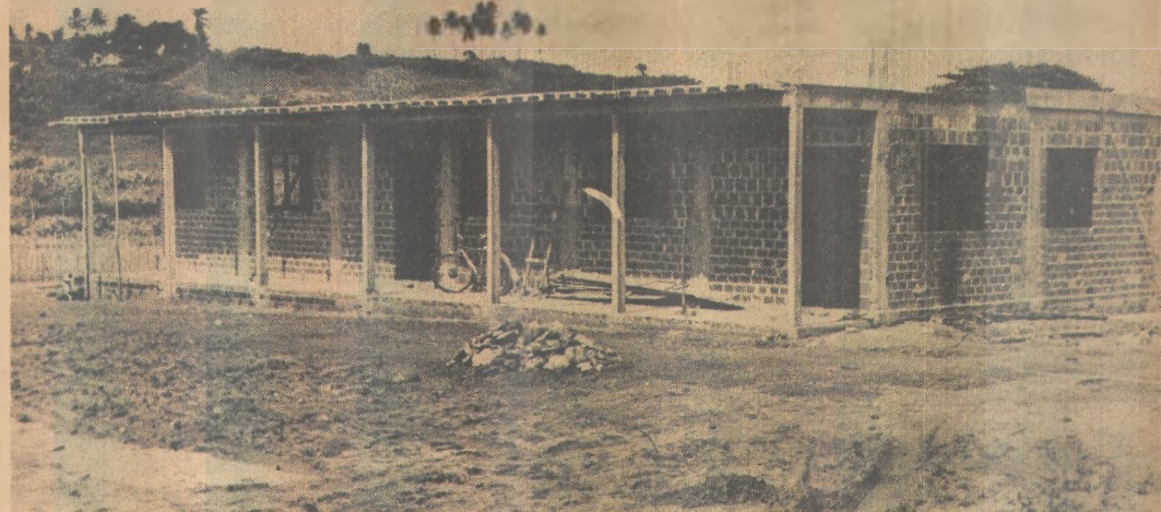
No Varadouro, o Auto constrói a sua sede-concentração
