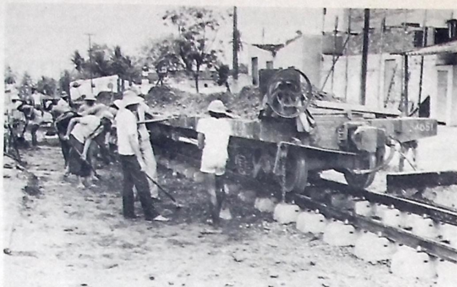
Toda a linha está sendo mudada. Os dormentes de madeira já foram substituídos
