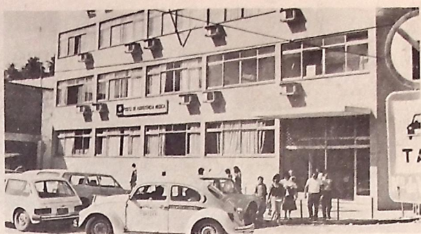
O posto da Primavera está prejudicado pela constante falta d'água
