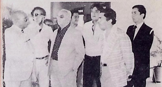
O governador Clóvis Bezerra visitou obras em Pedras de Fogo
