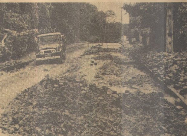
As obras dificultam o trânsito
