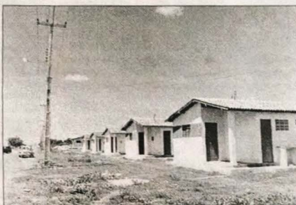
As casas fazem parte do conjunto habitacional dos delegados
