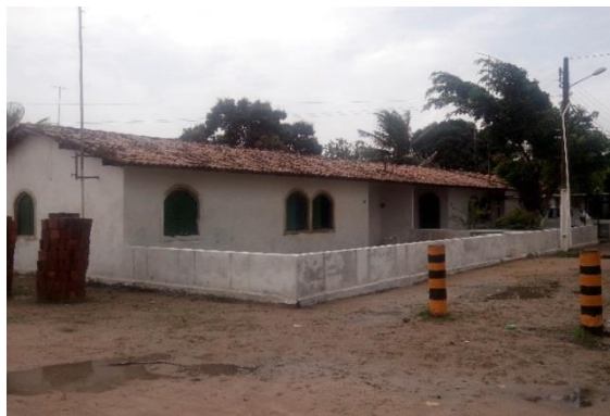
Casas modificadas, porém preservando a arquitetura
