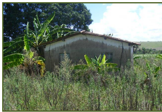
Casebre localizado na área prevista para inundação
