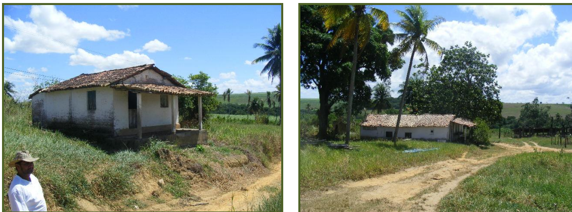
Casebre localizado na área prevista para inundação
