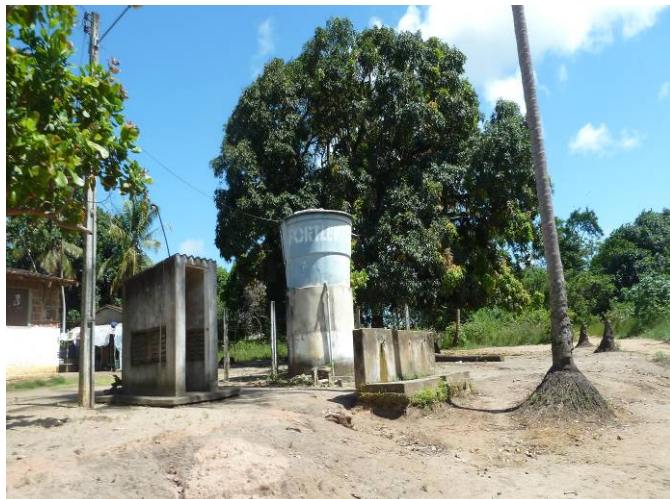
Foto 4.34 – Sistema de abastecimento de água dos moradores do Assentamento Sobradinho feito através da captação de água em poço profundo.
