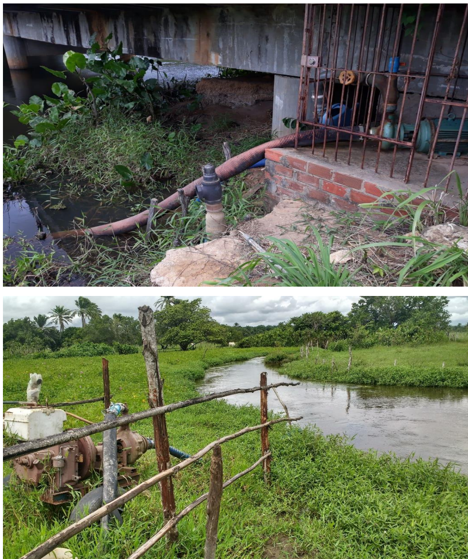
Figura 40: Captação de água bruta por meio de bombeamento no leito do rio Abiaí e Papocas
