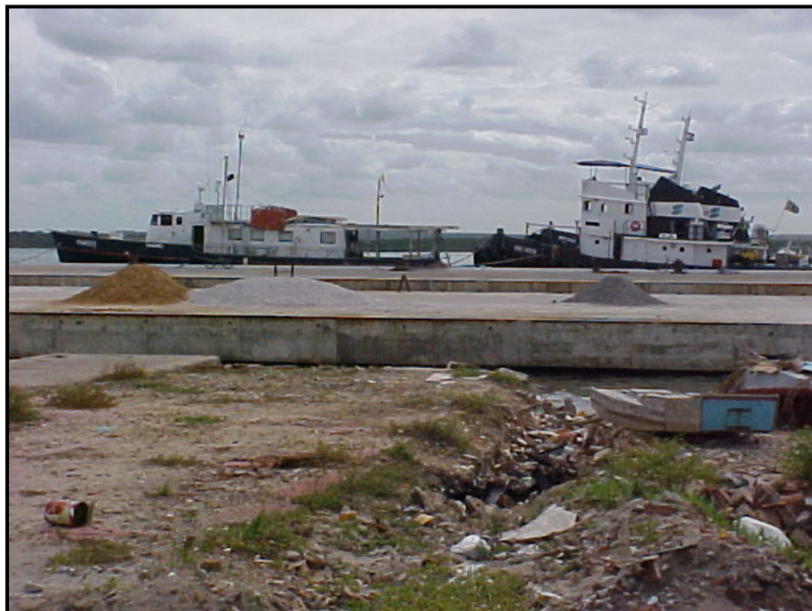
FOTO 17 – No porto, a atracação das embarcações se faz em cais de concreto, dentro de área protegida, mantendo o mesmo alinhamento do molhe.
