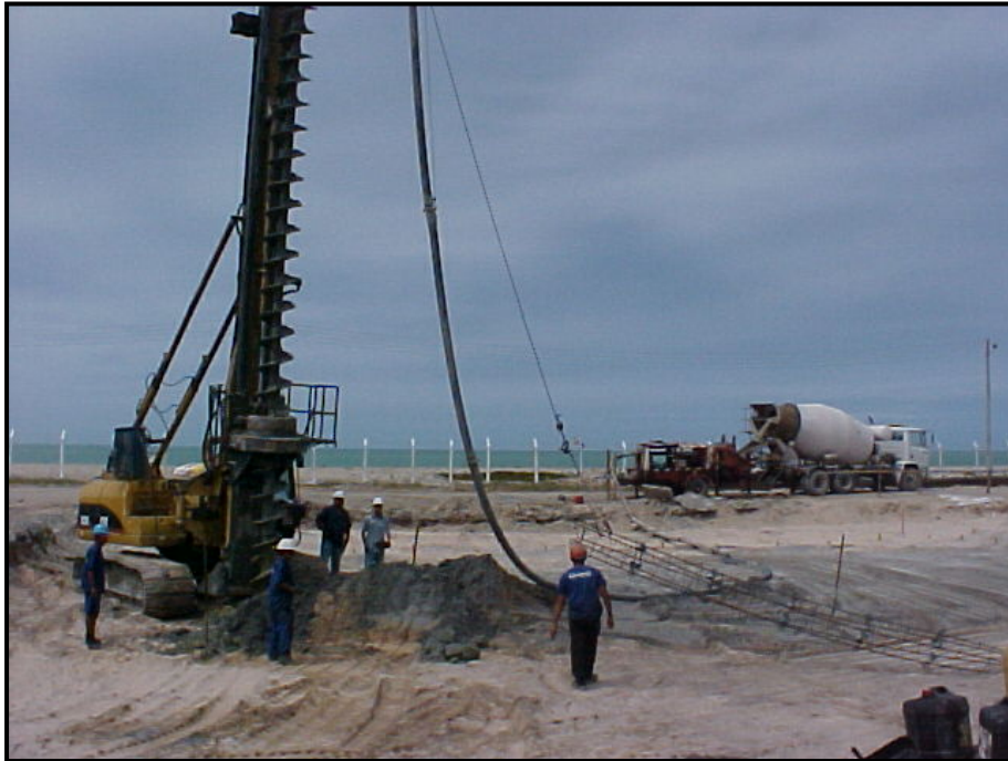
FOTO 39 – Fase iniciais das fundações, que se fazem por perfuração com sonda elicoidal, que simultaneamente, faz a injeção direta do concreto no furo., em terreno previamente limpo.
