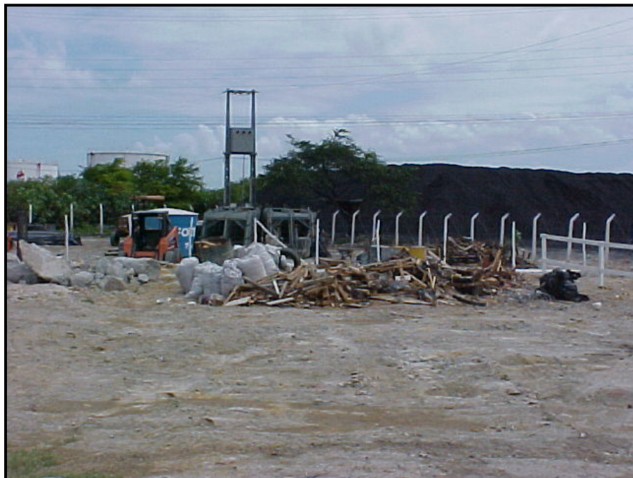
FOTO 45 – Materiais de construção inservíveis não são destinados aos depósitos do lixo comum e sim armazenados organizadamente (selecionados) no canteiro para recolhimento e destinação posterior pela própria empresa.
