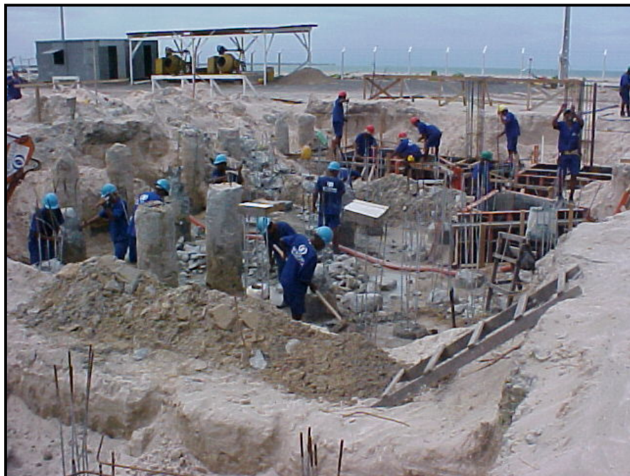
FOTO 41 – Depois de construídos os pilares, a área é escavada manualmente para recebimento das formas que receberão as bases de concreto das fundações.
