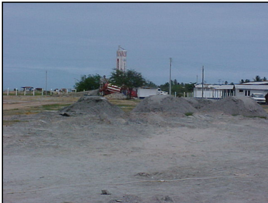
FOTO 37 – Vista tomada da parte central do canteiro de obras para sul, denotando a torre de concretagem e parte das instalações administrativas do canteiro. As pilhas de material são recolhidas das escavações das fundações dos pilares e armazenadas temporariamente para sistematização em uso nas fases seguintes.
