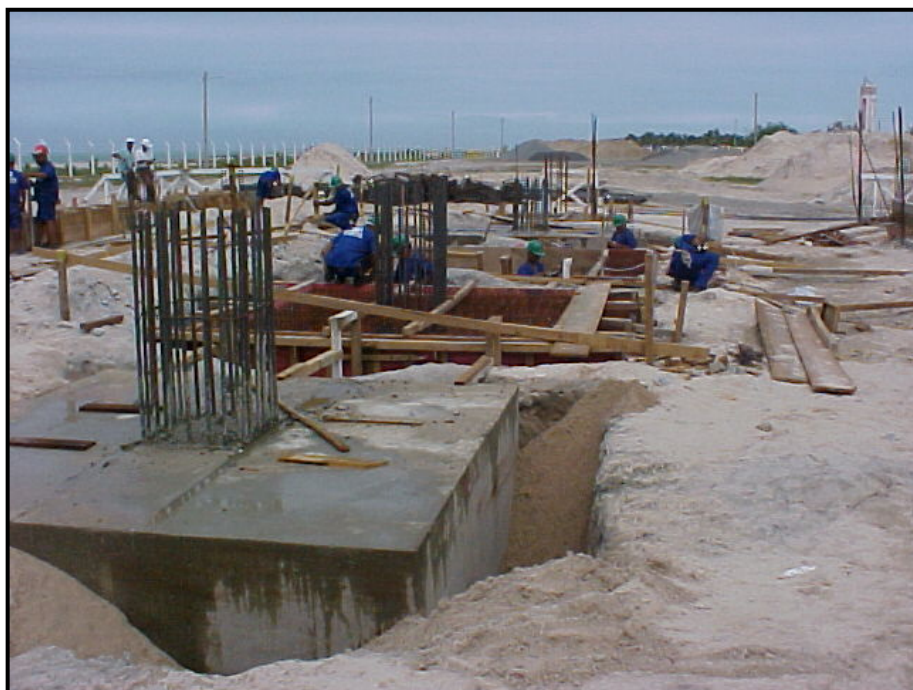
FOTO 42 – Vista da fase final das bases das fundações no terreno, cada uma sustentada por vários pilares.
