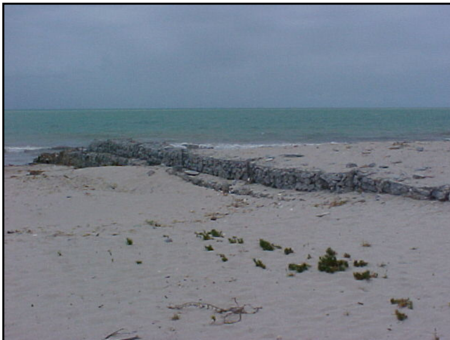
FOTO 13 – Na face de praia: foram implantados molhes de proteção de costa para fazer frente ao avanço do mar. As estruturas protegidas por gabiões interferiram com o potencial turístico da área.
