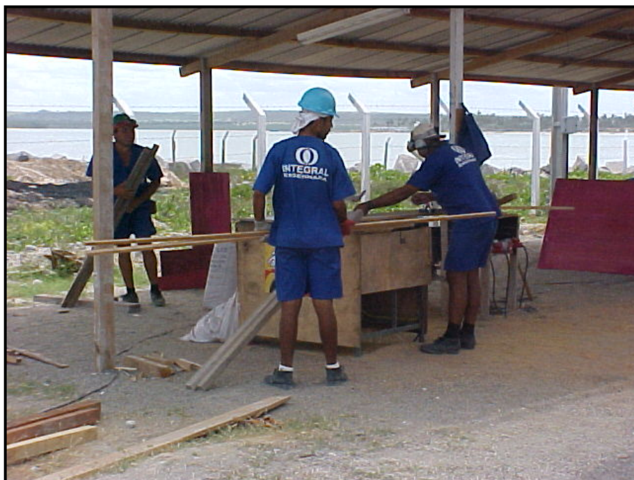
FOTO 52 – Sob a placa da FOTO anterior se observa o efeito, com os trabalhadores efetivamente utilizando máscaras, botas, capacetes e protetores auriculares. Trata-se da serraria e serralheria.
