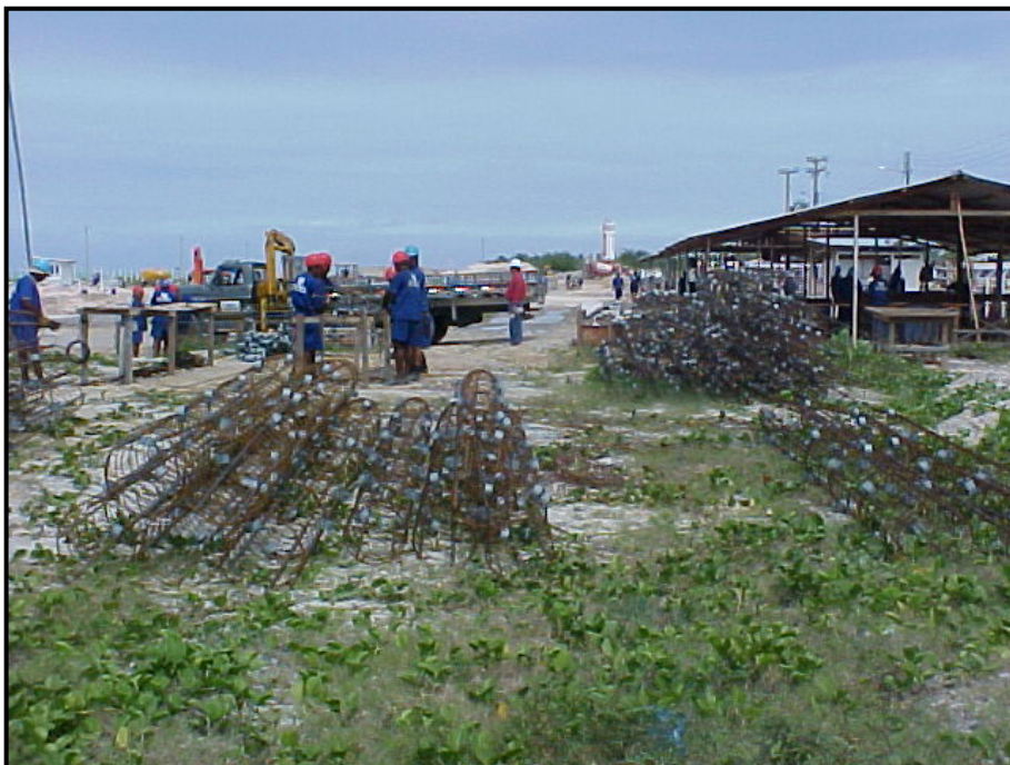
FOTO 40 – Durante a injeção de concreto são introduzidas às armações de ferro, construídas na própria frente de serviços, armando os pilares individuais das fundações.
