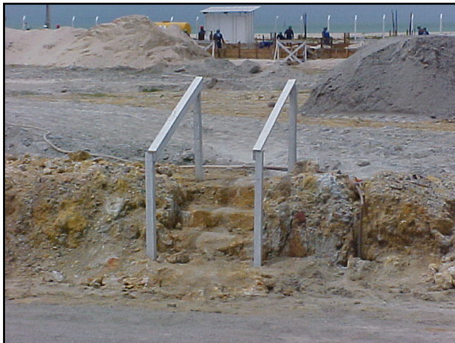
FOTO 47 – Outra forma de organização racional no canteiro é a construção de passagens simples e protegidas nos ressaltos topográficos entre os escritórios e a frente de obras, minimizando o risco de acidentes.
