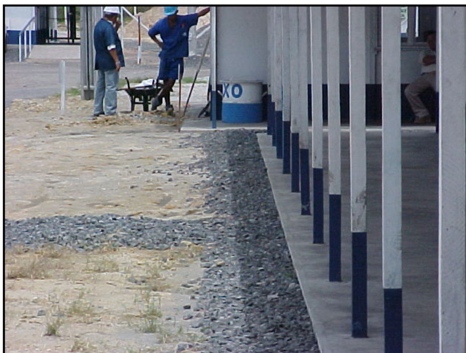
FOTO 48 – As partes impermeabilizadas e que poderiam contribuir para gerar frentes de erosão com o escoamento de águas, recebem tratamento com britas, evitando o sulcamento do terreno. A sombra marca o limite do telhado. Notar também ao fundo mais um depósito de lixo.
