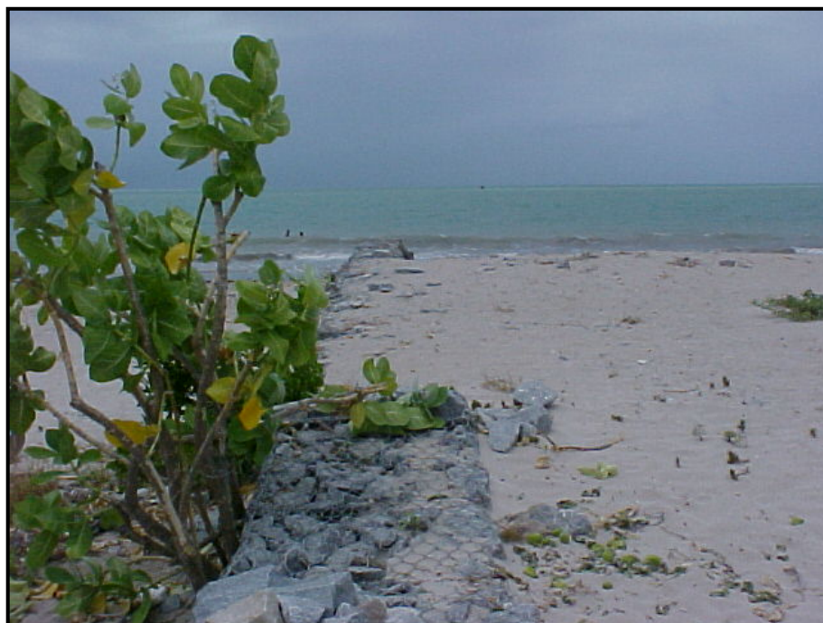
FOTO 14 – Como resultante do processo de proteção, às praias estão acumulando areias na face de barlamar dos molhes, progradando e evitando o risco de erosão, de forma que o objetivo desse programa foi atendido e as praias estão devidamente protegidas.
