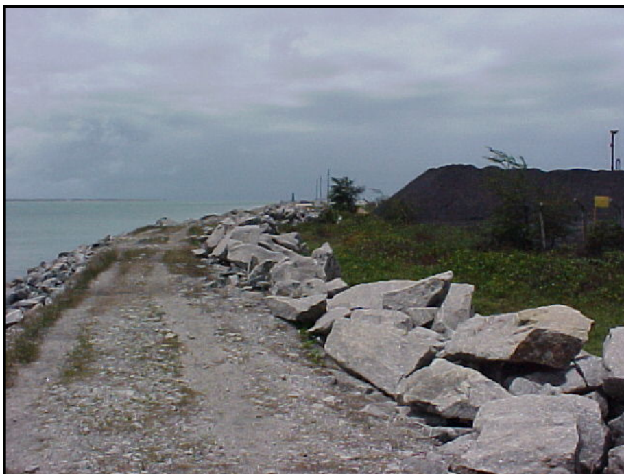
FOTO 16 – Ao longo de sua estrutura o molhe do porto é composto por enrocamento de pedras, permitindo tráfego superficial precário, para veículos de pequeno porte.
