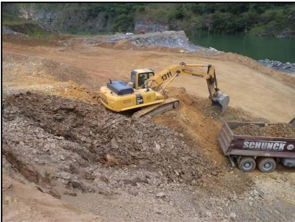
**FOTO 4.1.3** – Escavadeira hidráulica utilizada na Unidade Santa Helena – SP e semelhante a que será utilizada no carregamento de estéril na Unidade Caaporã.
