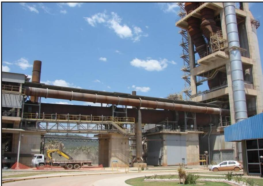
**FOTO 4.2.2.2** – Vista do forno de clínquer da Unidade Xambioá – TO da VOTORANTIM CIMENTOS semelhante ao que será utilizado na fábrica de cimento de Caaporã.
