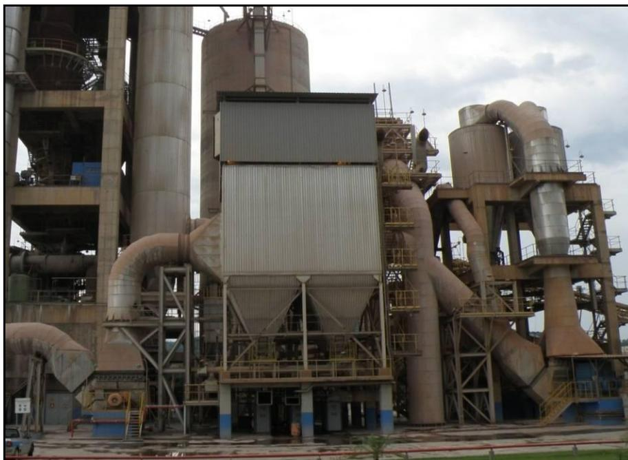
**FOTO 4.2.2.3** – Filtro de mangas da Unidade Xambioá - TO da VOTORANTIM CIMENTOS e semelhante ao que será utilizado na fábrica de cimento em Caaporã.
