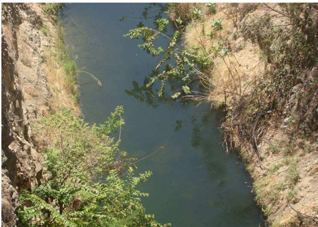
**Foto 5** – Assoreamento do canal por rochas e material arenoso
