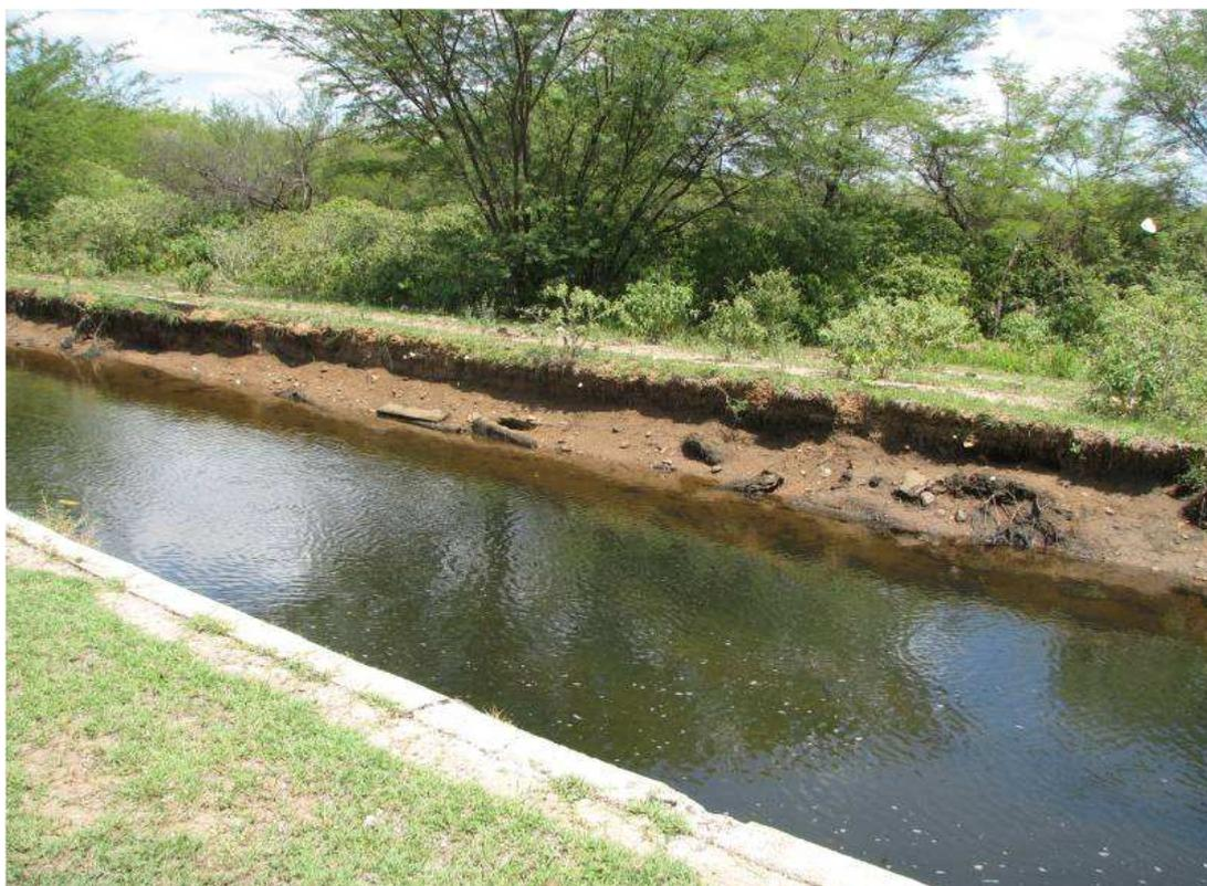
**Foto 4** – Ausência de placas de concreto na lateral do canal
