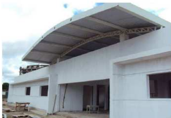
Acabamento do bloco administrativo
