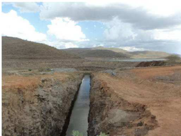
Início do Canal – Açude Acauã, Ensecadeira e a Execução da Obra da Tomada D'Água do Canal
