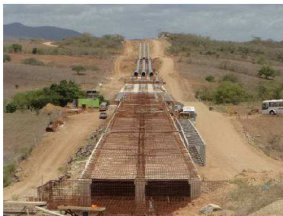
Sifão Surrão – Ponte sobre o Rio Surrão – Apoio às Linhas de Tubulação Metálica - DN = 1900mm (Estacas – E-252 a E-271)
