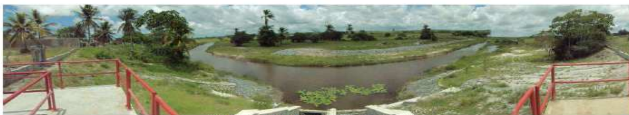
Vista panorâmica do canal de aproximação
