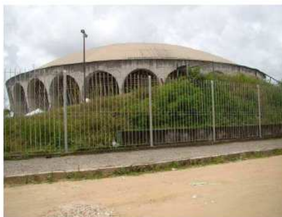
Gradil metálico de contorno do ginásio
