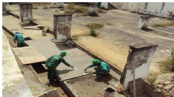
Recuperação da estrutura interna
