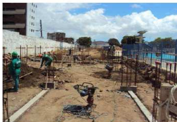
Estrutura para arquibancada
