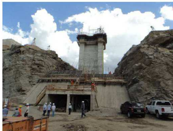
Início do Canal – Estrutura em Concreto p/ as Comportas Planas Verticais da Tomada D'Água do Canal (Lado Jusante)
