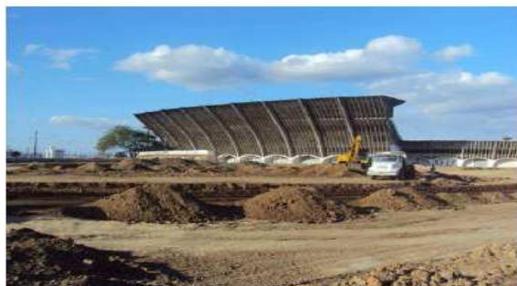
Terraplanagem da área externa
