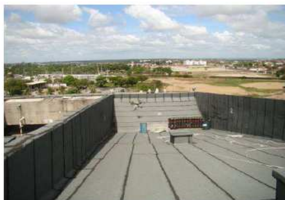
Impermeabilização de laje
