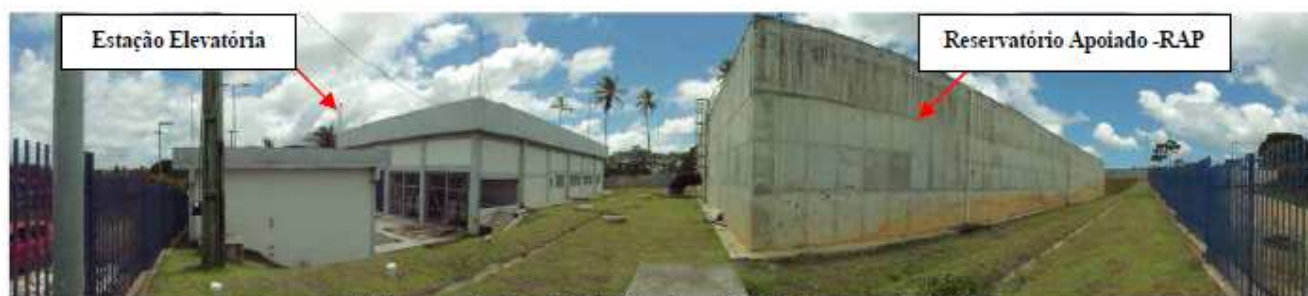
Vista panorâmica da Estação elevatória 04 junto com o RAP
