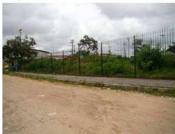
Gradil metálico de contorno do ginásio
